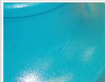
La peinture est appliquée sur une surface apprêtée. La peinture devra déborder sur la surface environnante.
