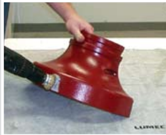
Nettoyage mécanique de la surface
