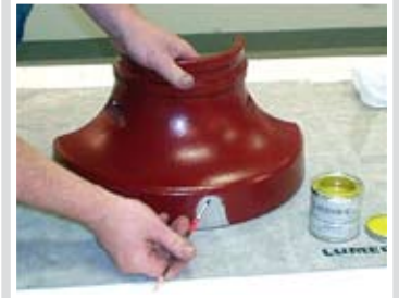
L'apprêt est appliqué sur la surface nettoyée
